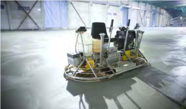
Zwischen Betoneinbau und Glättbeginn sind Maßnahmen gegen vorzeitiges Austrocknen der Betonoberfläche zu ergreifen. Es empfiehlt sich das Auflegen einer PE-Folie.
